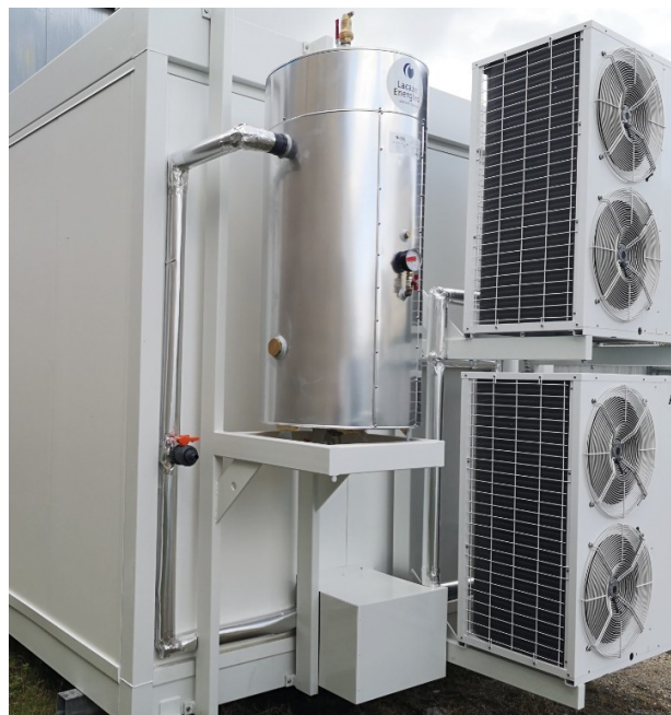
Deux chillers 20kW avec ballon inertiel monté sur shelter ECUS (La Fab' MDC)
